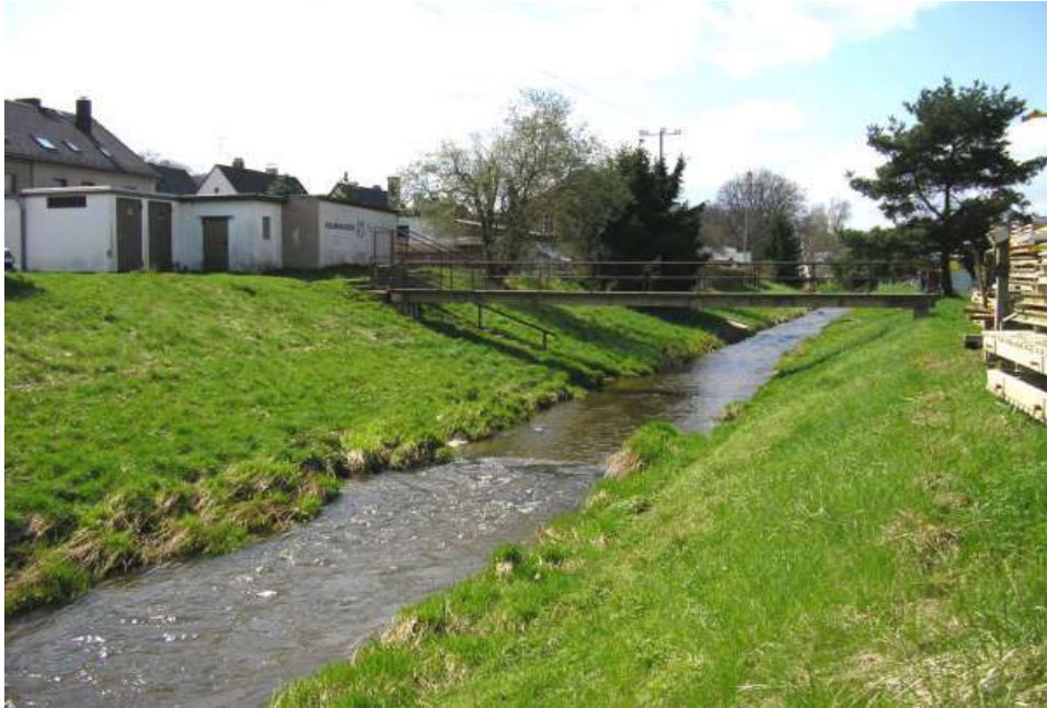
Messstelle in MAK
