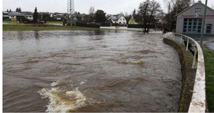
290 cm: Beginn Überschwemmung, Feuerwehrhaus Wölsauerhammer
